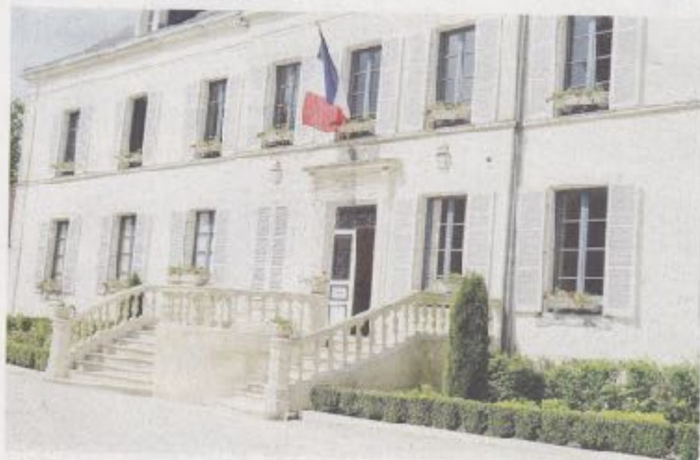
Le château Saint-Louis abrite la mairie du village.
